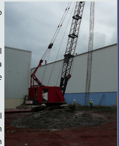
Colocación de Acero de refuerzo
