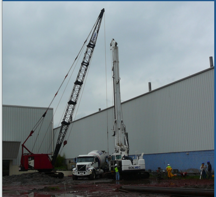
Colado y Perforación
