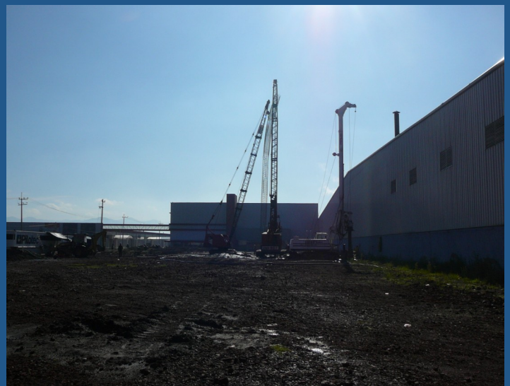
Vista de la zona de trabajo
