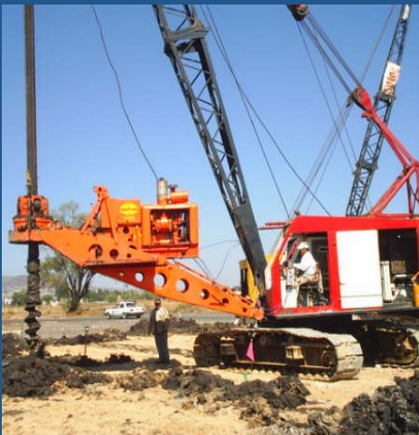
Perforación de inclusiones
