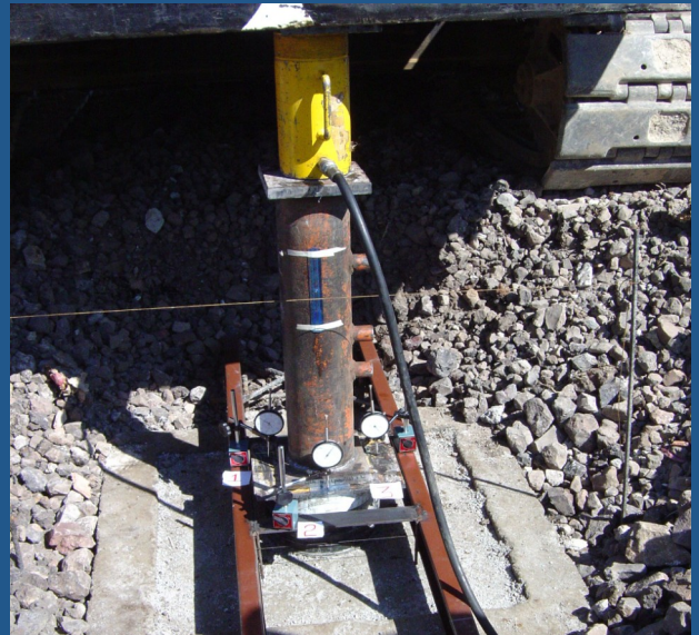
Ejecución de prueba de carga
