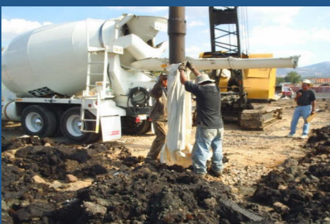
Cimentación de tanque
