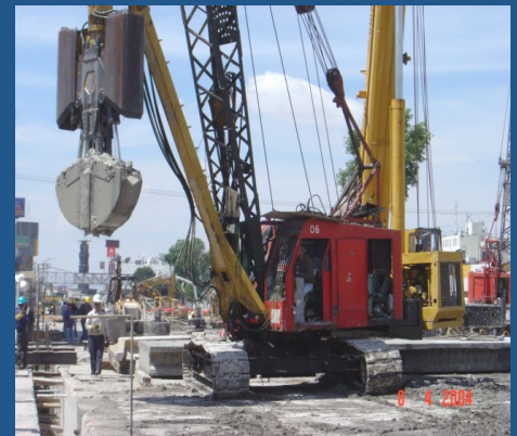
Almeja guiada, excavación para muro precolado
