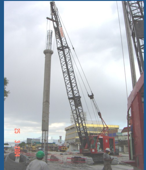
Montaje de Columna Prefabricada
