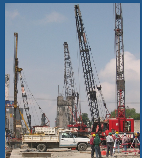
Colocación de Pantalla Impermeable
