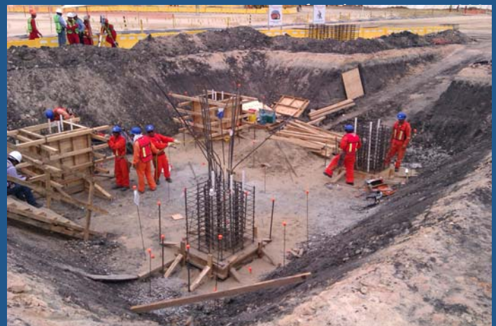
Construcción de dados de reacción
