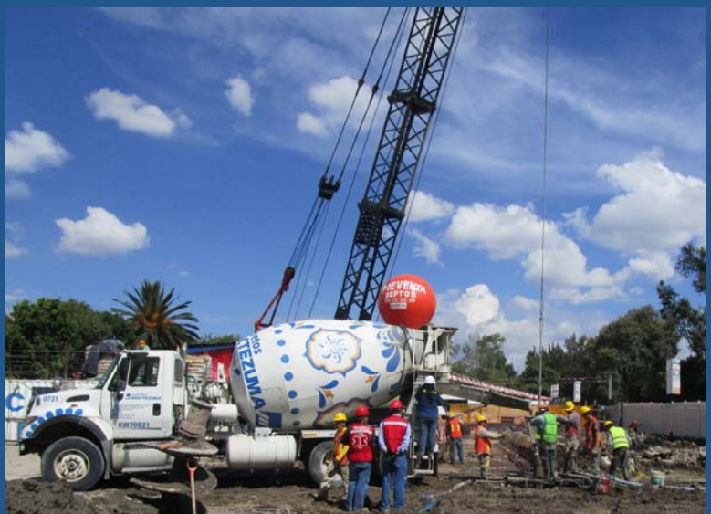
Colado de pila de cimentación
