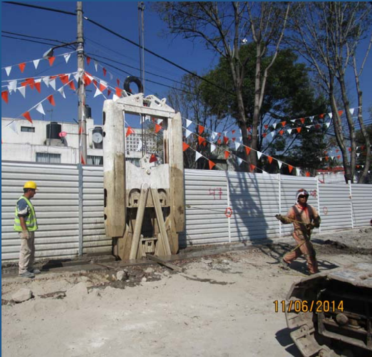
Excavación de muro Milán
