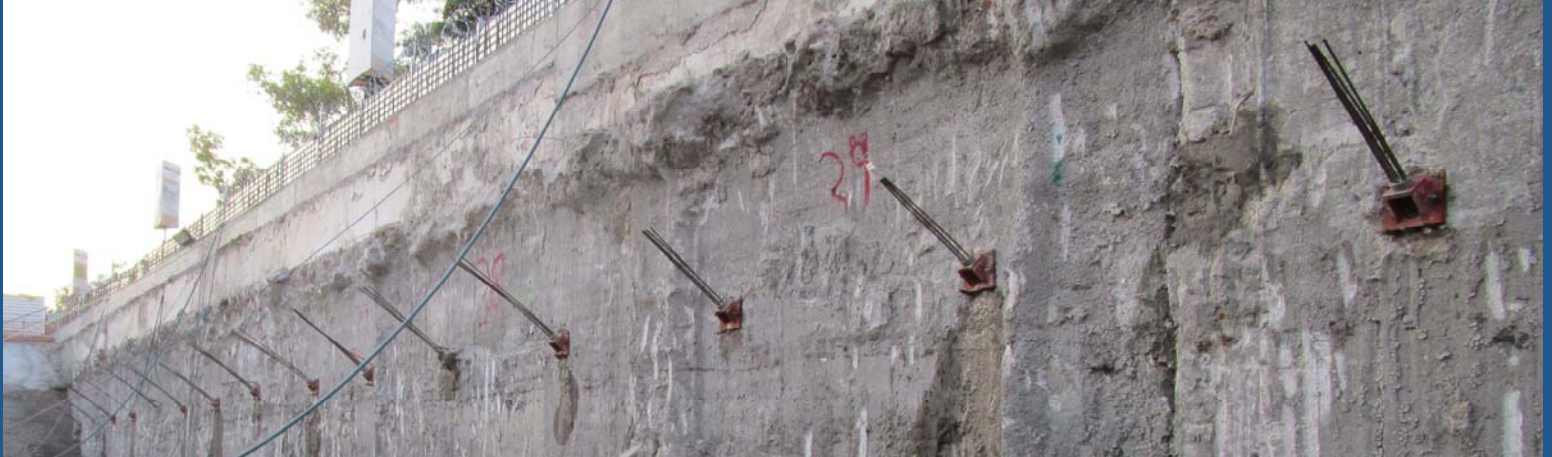
Sistema de anclaje en muro Milán
