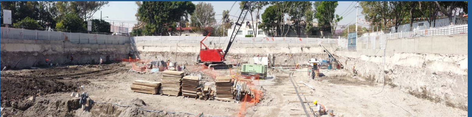
Proyecto en etapa de anclaje
