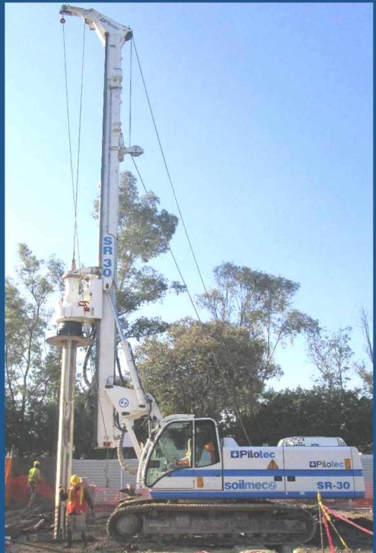
Pilas de cimentación
