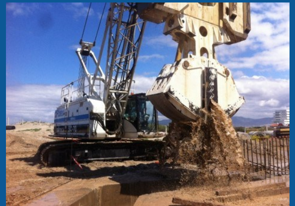
Excavación con almeja hidráulica de sección de 1.00 m
