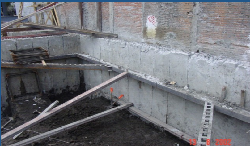
Excavación y apuntalamiento
