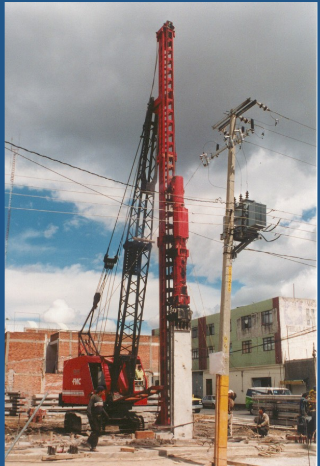
Hincado de tablestaca
