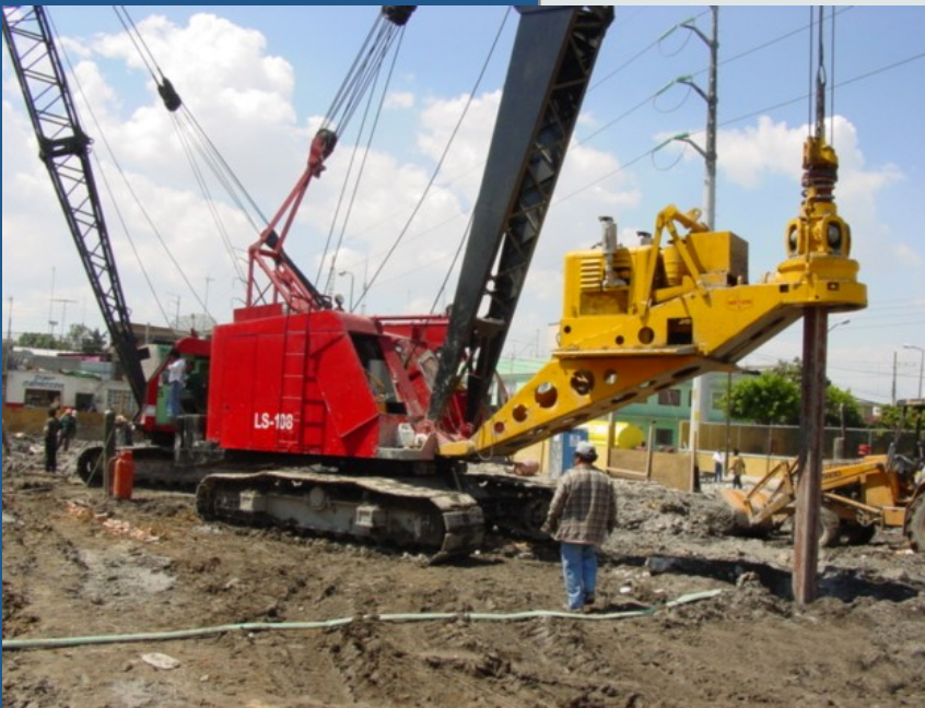
Perforación de pilas
