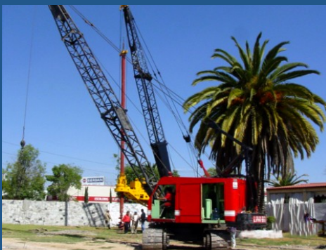
Equipo de perforación
