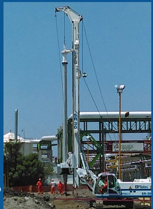
Proceso de construcción de pilas de prueba y de reacción
