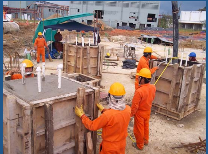
Construcción de dados de reacción
