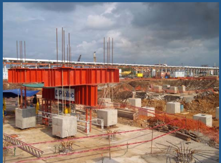
Prueba a compresión, en pila
