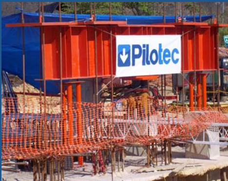
Prueba a compresión, en pilote
