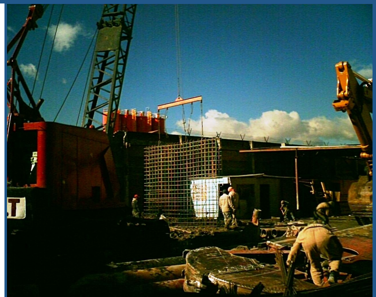
Colocación de Acero de Refuerzo en Excavación
