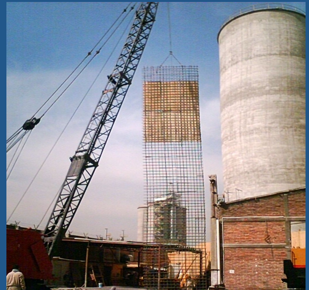
Izaje de Armado de Muro Milán
