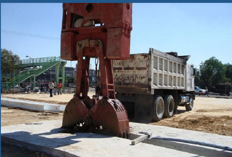
Excavación de pantalla impermeable
