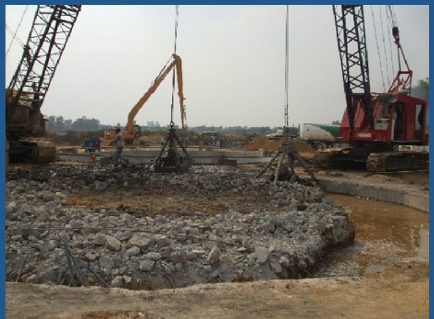
Excavación de núcleo con almeja suelta
