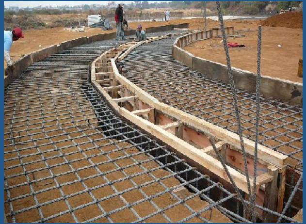
Construcción de brocal en pantalla
