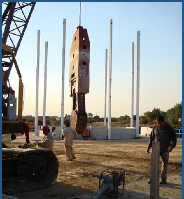
Colocación de anillos
