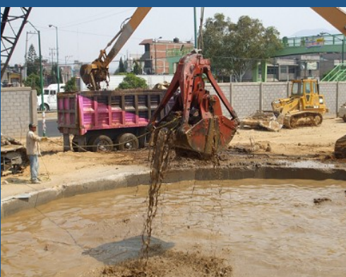
Excavación de núcleo de estructura
