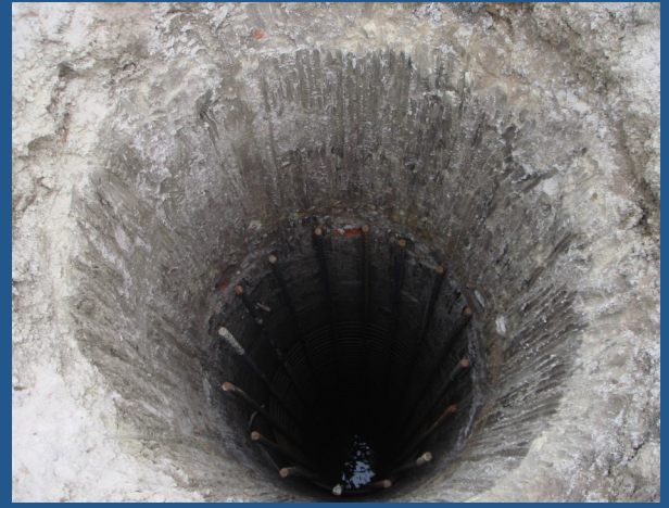
Colocación de armado en perforación
