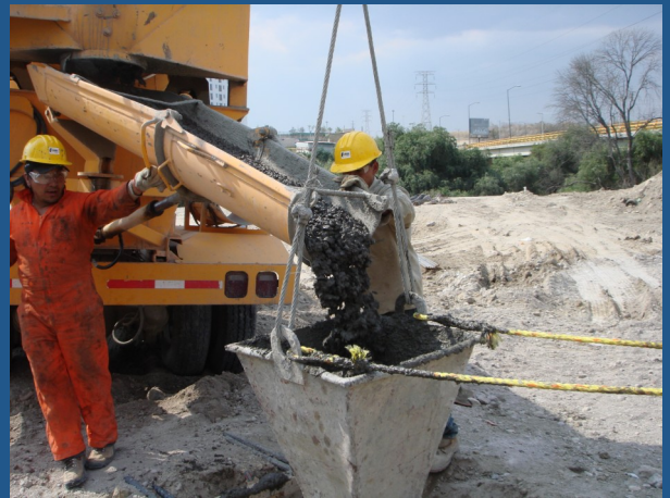
Colocación de concreto
