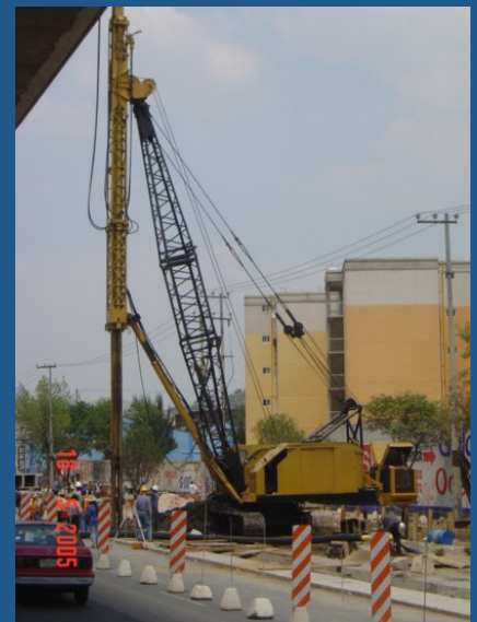
Excavación con almeja hidráulica
