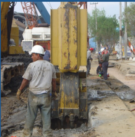
Excavación de zanja con lodo bentonítico
