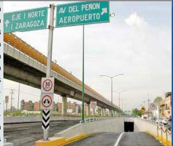
Acceso al paso subterráneo
