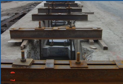
Viguetas metálicas conectadas al muro
