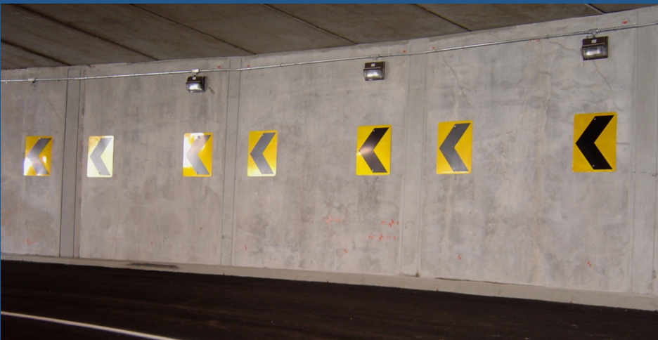
Muro Millán prefabricado terminado
