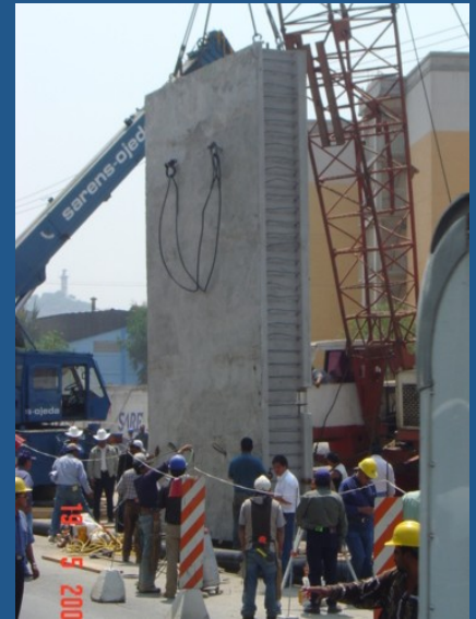
Montaje de Muro prefabricado
