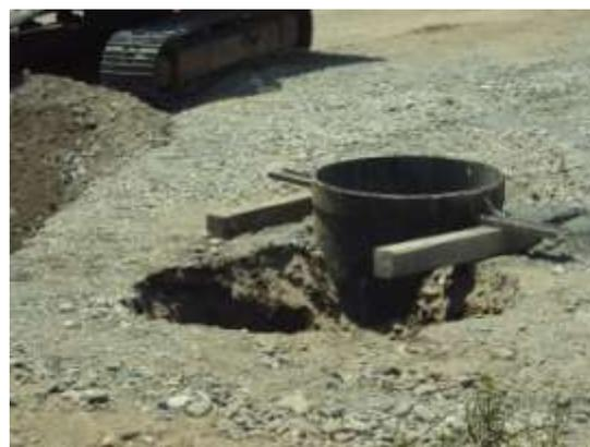
Fig. 5, Falla de fondo en la perforación de una pila, comunicada a la superficie.
