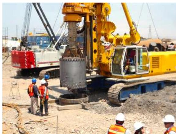
Fig. 4, Construcción de pilas de cimentación en relleno hidráulico, utilizando ademe metálico parcial, y lodos.
