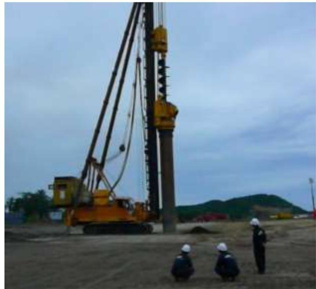
Fig. 7, Procedimiento constructivo I: perforación con hélice continua y ademe, utilizando una cabeza rotaria doble.
