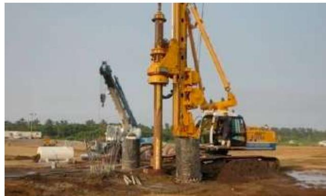
Fig. 8, Procedimiento constructivo II: perforación con Kelly telescópico, lodo bentonítico y ademe metálico en una porción de la perforación.
