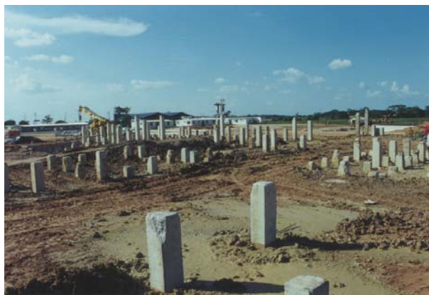
Fig. 4. Vista general del campo de pilotes en el turbogenerador
