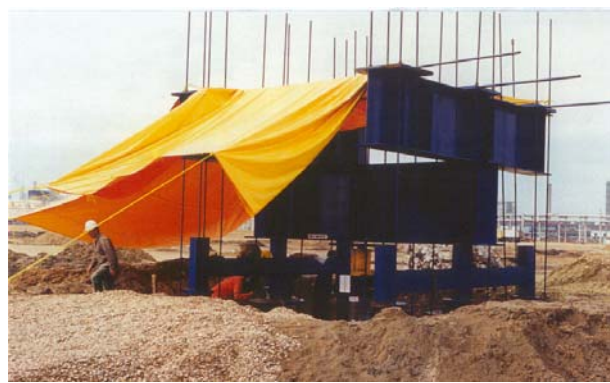
Fig 14. Prueba de carga de compresión
