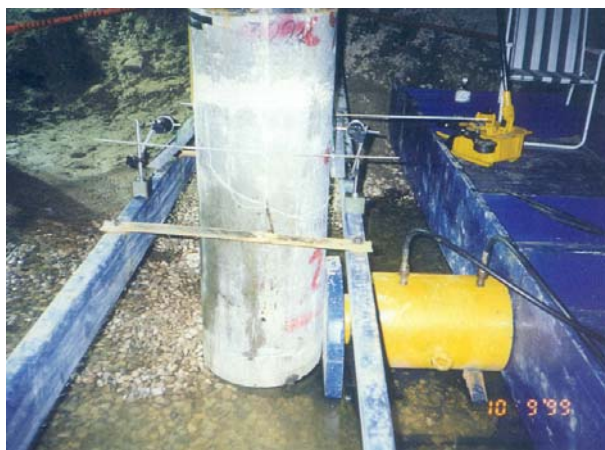
Fig 16. Prueba de carga lateral
