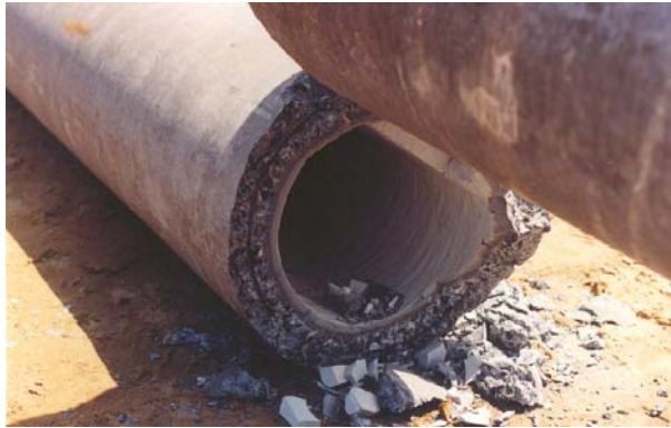
Fig 6. Pilote centrifugado en Refinería Madero
