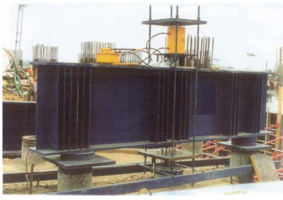
Fig 15. Prueba de carga de tensión
