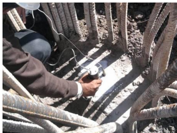
Figura 4. Ejecución de prueba de integridad.
