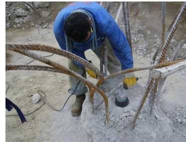
Figura 5. Preparación de la superficie de la pila para ejecución de prueba.
