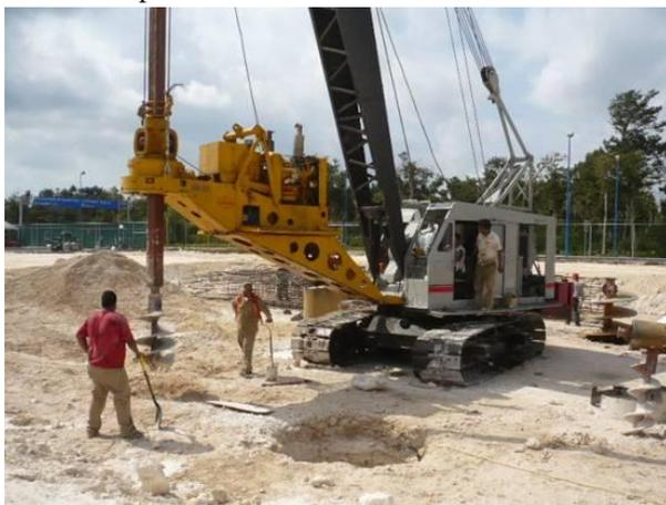
Figura 5.1. Proceso constructivo de pilas
