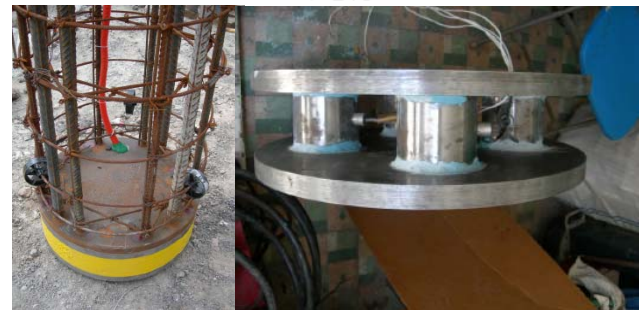
Figura 3 Celda colocada en la punta de la pila, previo a la introducción en la perforación
