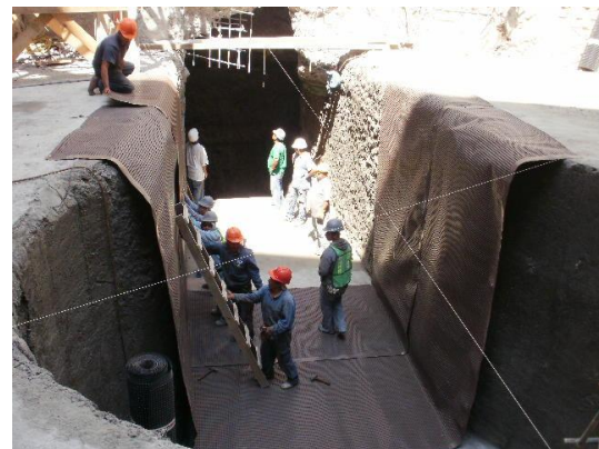
Figura 6.5, Instalación de geomembrana
