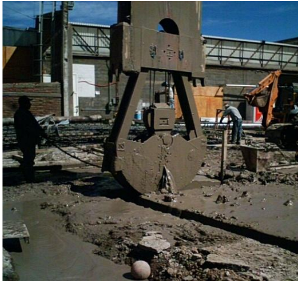
Figura 6.2 Excavación de muro Milán
