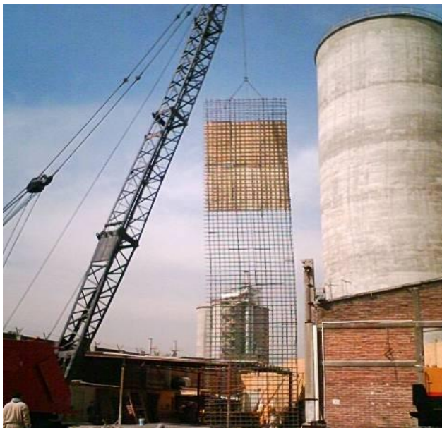
Figura 6.3 Izaje de armado de muro Milán
