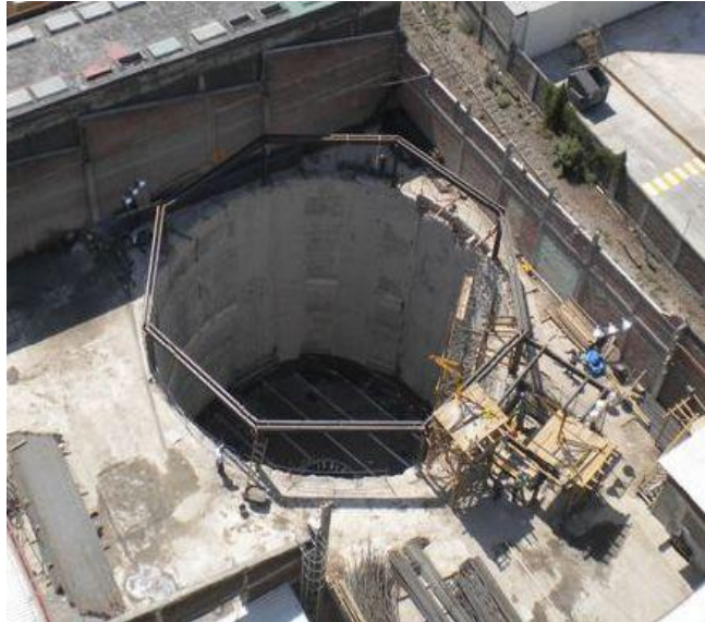
Figura 6.4 Excavación de silo a nivel de losa de fondo
