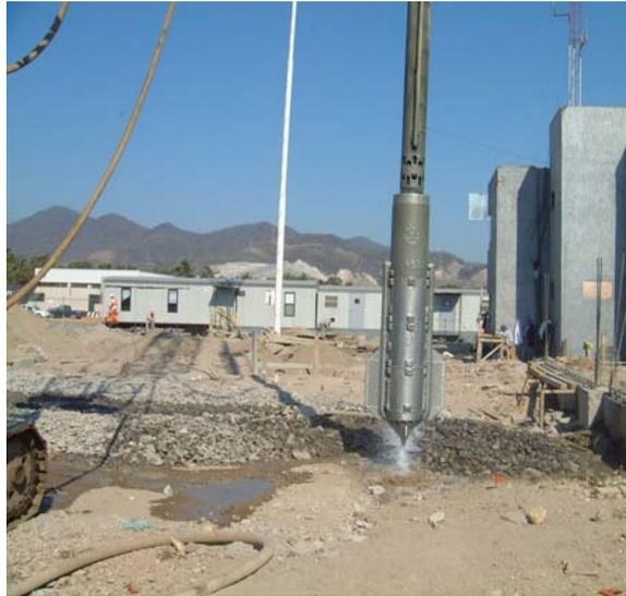
Fig 17, Vibrador de fondo en Terminal de Contenedores, Manzanillo, 1998
