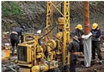
Fig 4, Colocación de geotextil para pila
