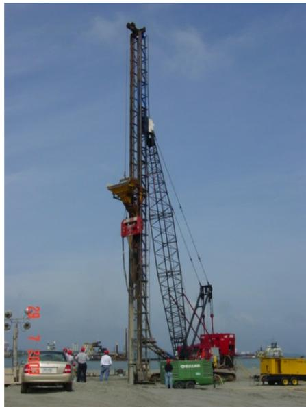
Fig 18, Vibro-reemplazo en la Terminal de Contenedores Colón, 2000
