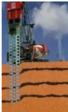
Fig 15, Compactación con probeta vibratoria
