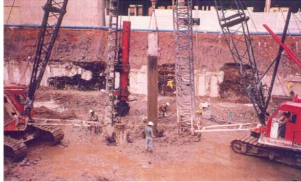
Fig 12, Extracción de pilotes, Galindo (1988)
