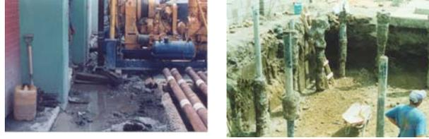
Fig 10, Construcción de micropilotes en la ciudad de México
