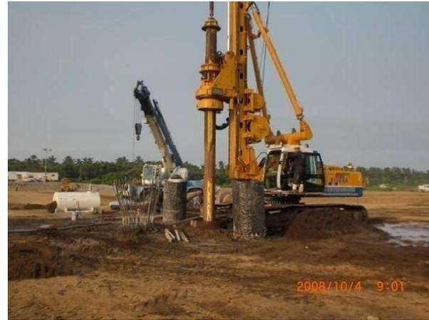
Fig. 6. Construcción de pilas
