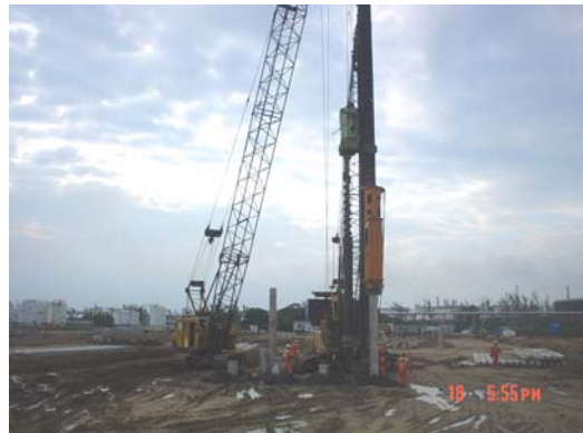
Figura 5. Vista del proceso de construcción de pilotes
