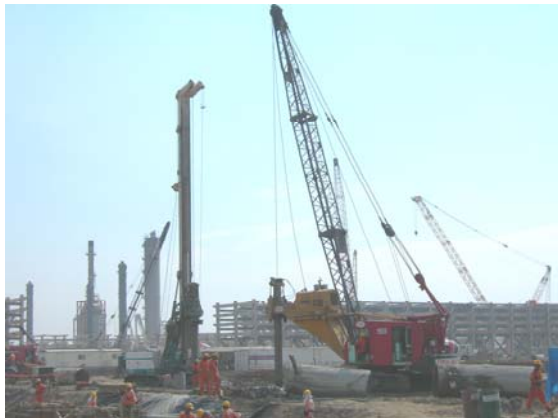
Figura 4. Vista del proceso de construcción de pilas
