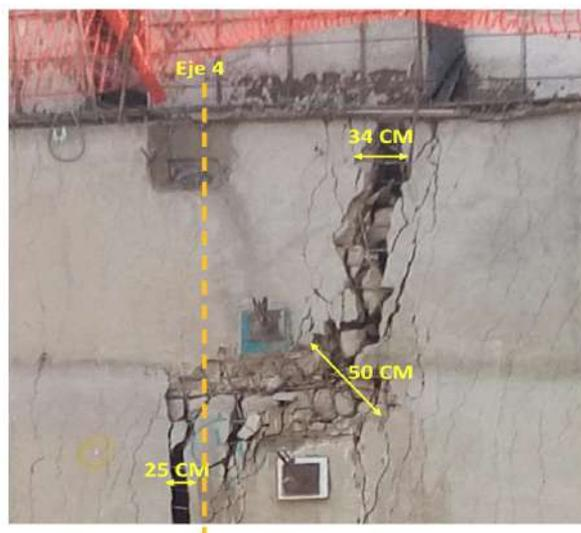
**Figura 6.** Detalle del agrietamiento en el muro de concreto lanzado por el deslizamiento y giro
