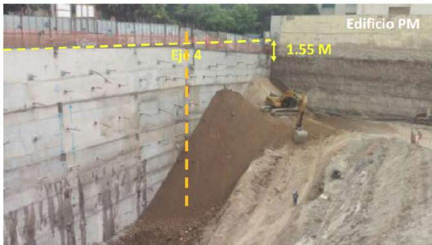
**Figura 5.** Giro del muro de concreto lanzado; se aprecia el recargue de material estabilizador
