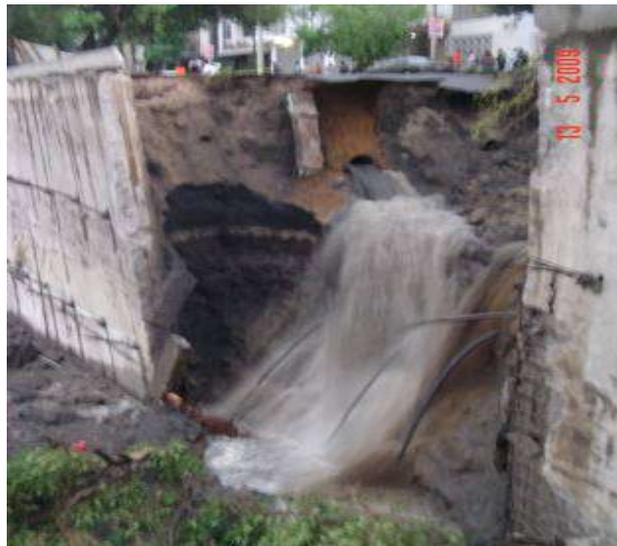
**Figura 4.** Falla del muro diafragma y anclas postensadas
