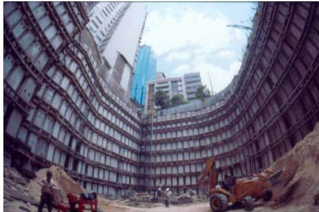
**Figura 3.** Muro diafragma prefabricado con vigas mdrinas y anclas
