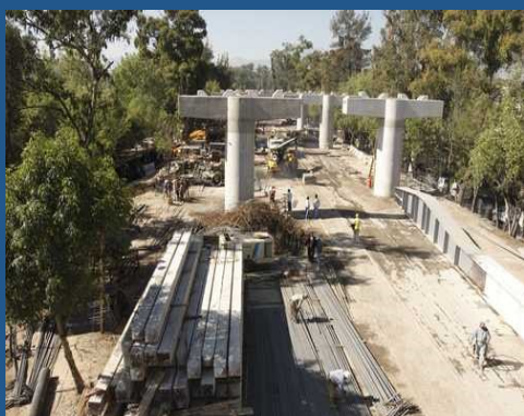
Vista de puente vehicular
