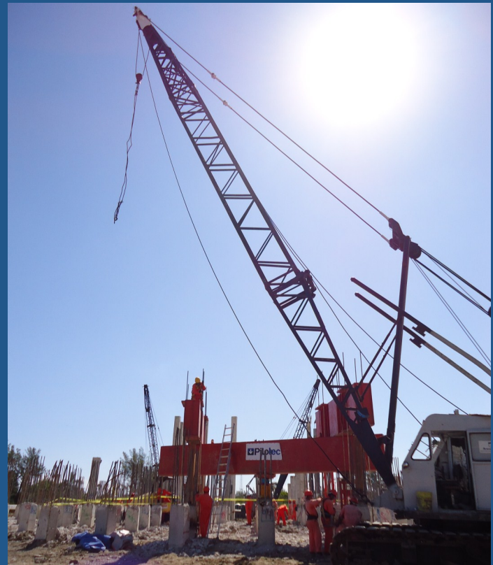
Montaje del sistema de reacción
