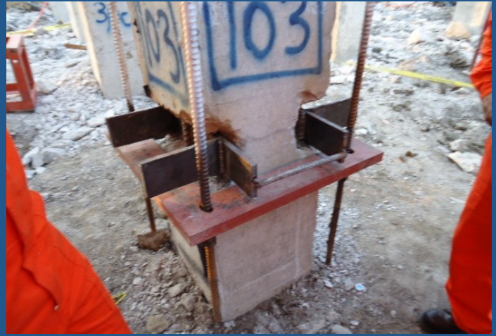
Preparación de pilote de reacción
