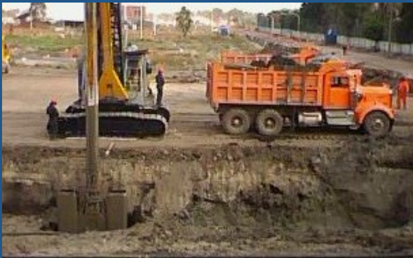
Excavación de pantalla
