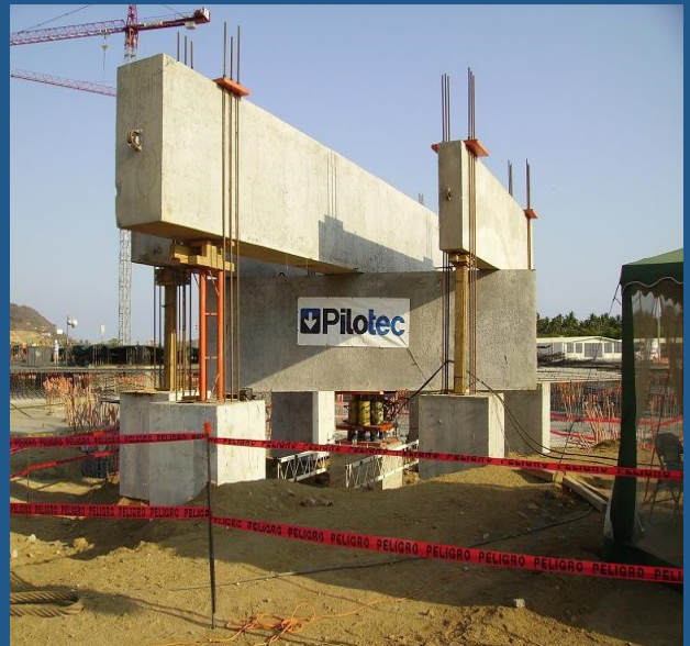
Prueba de carga a compresión
