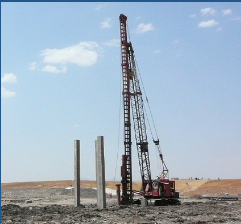
Hincado de pilotes
