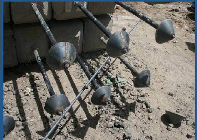
Fabricación de punta metálica en pilote
