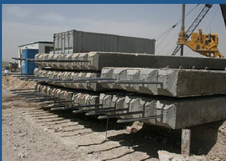
Cimbrado de pilotes
