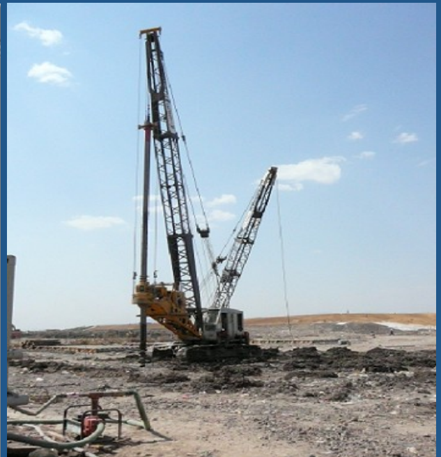
Perforación previa al hincado
