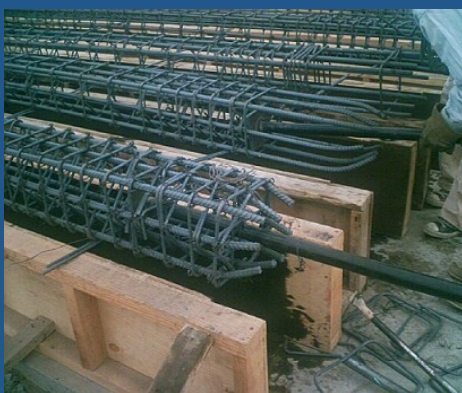
Armado y cimbrado de pilotes
