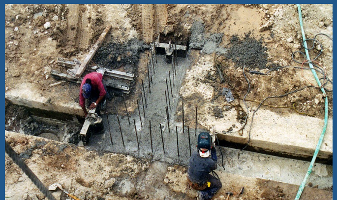
Colocación de concreto
