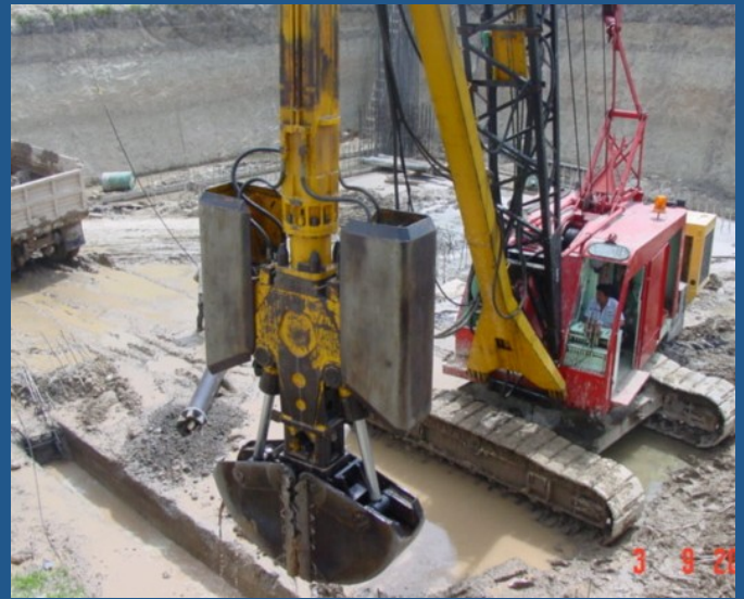
Excavación con almeja hidráulica
