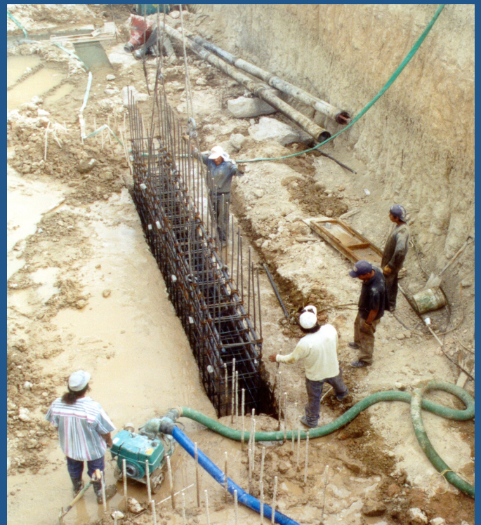
Colocación de acero en excavación
