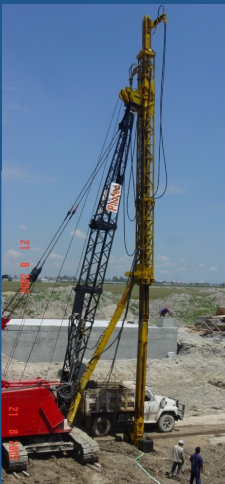
Excavación de muro milán
