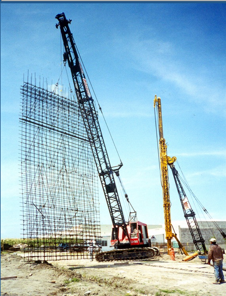
Izaje del armado del Muro Milán
