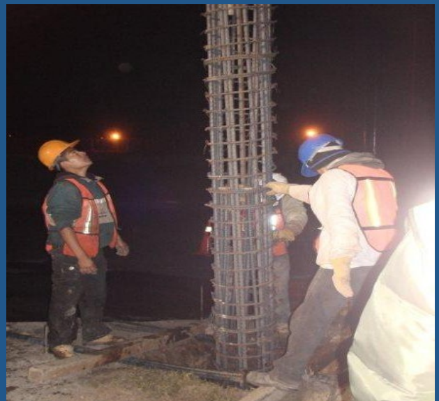
Colocación de acero
