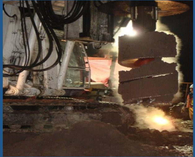
Perforación en pila
