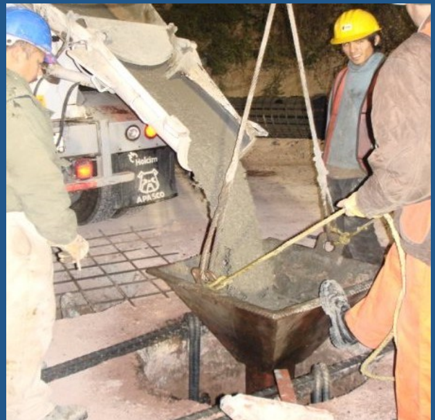
Colocación de concreto
