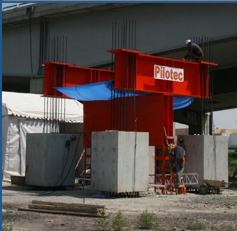
Arreglo para prueba de carga
