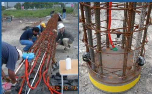
Instrumentación en pila de prueba
