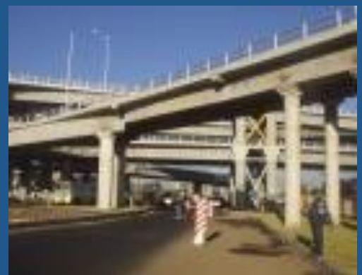
Vista del Distribuidor Zaragoza
