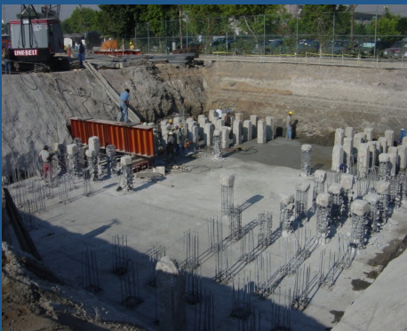
Montaje de prueba de carga
