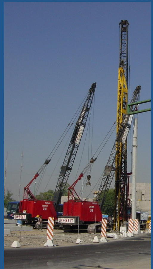
Hincado de pilotes
