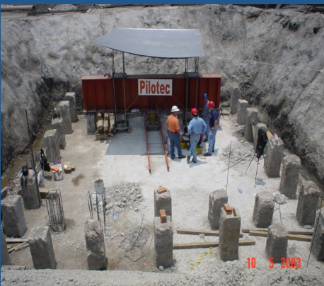
Montaje Prueba en pilote
