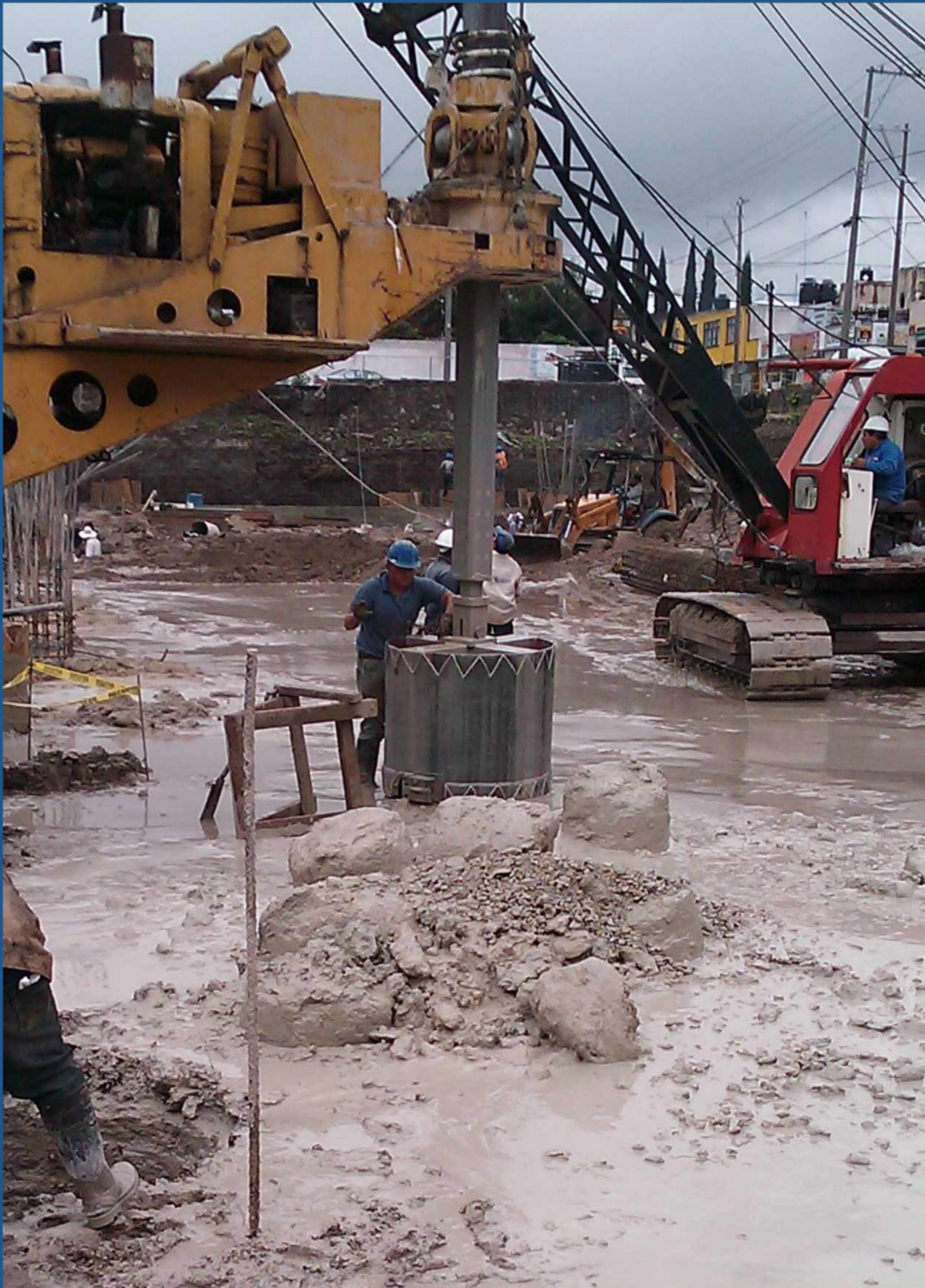
Perforación de pilas
