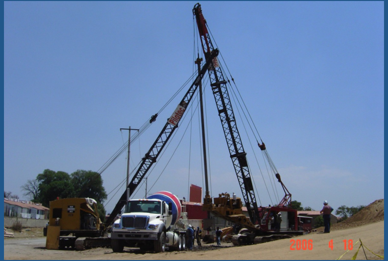
Colocación de concreto en pilas para apoyo de
