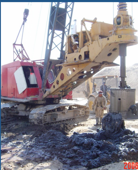
Excavación para Pilas de Cimentación
