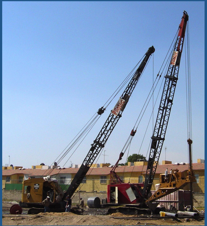
Perforación de pilas para puente
