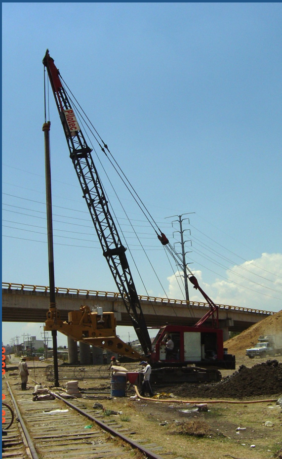
Perforación de pilas para puente
