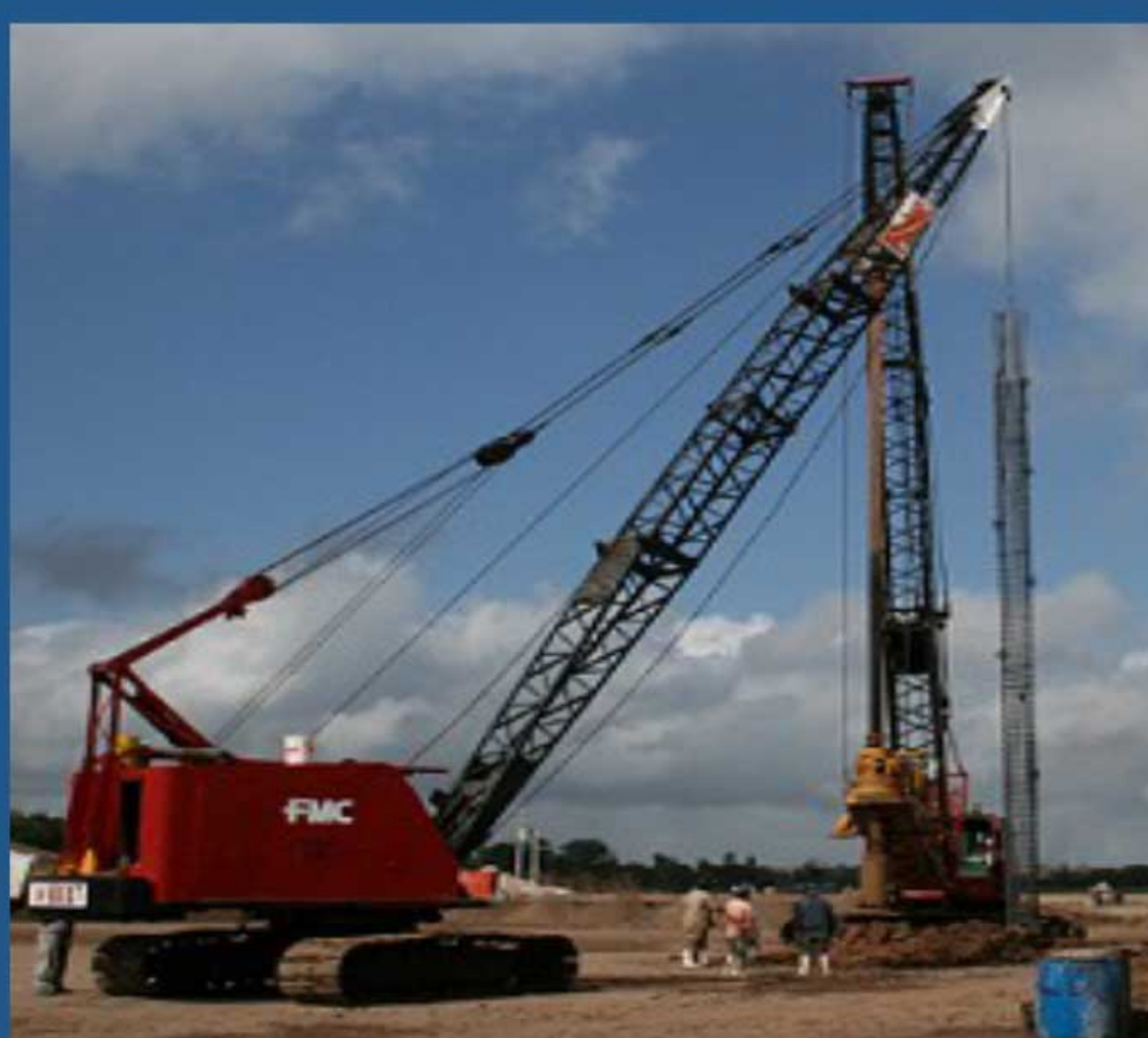
Construcción de pilas
