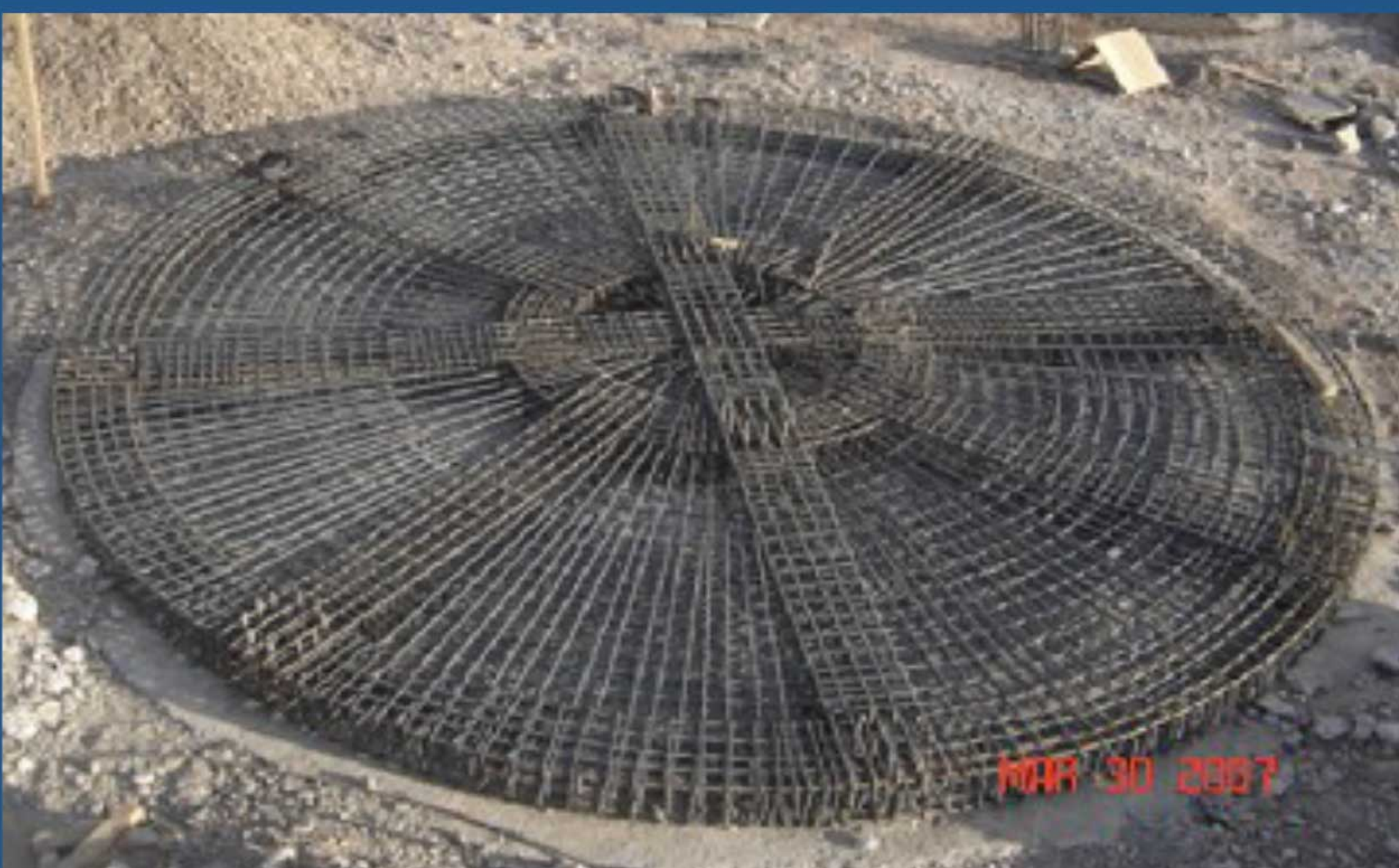
Cimentación de tanque
