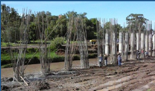
Perforación en puente Zahuapan
