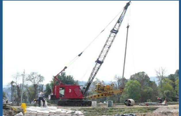
Perforación de pilas
