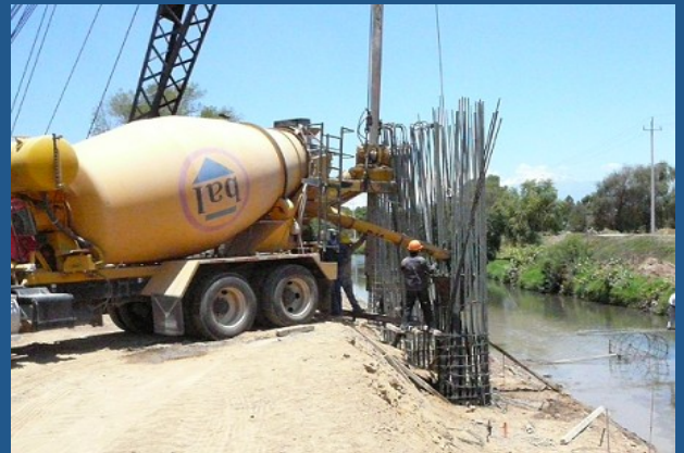
Colocación de concreto Zahuapan
